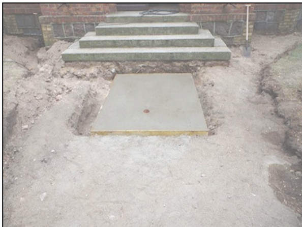
Und das ist das neue Fundament
